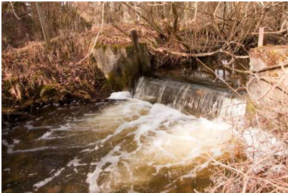
Figur 58. Fördämningen i Bandlundsån utgör ett vandringshinder för de flesta fiskar. Dammen och strömsträckorna uppströms utgör fina lekrområden för fisk.
