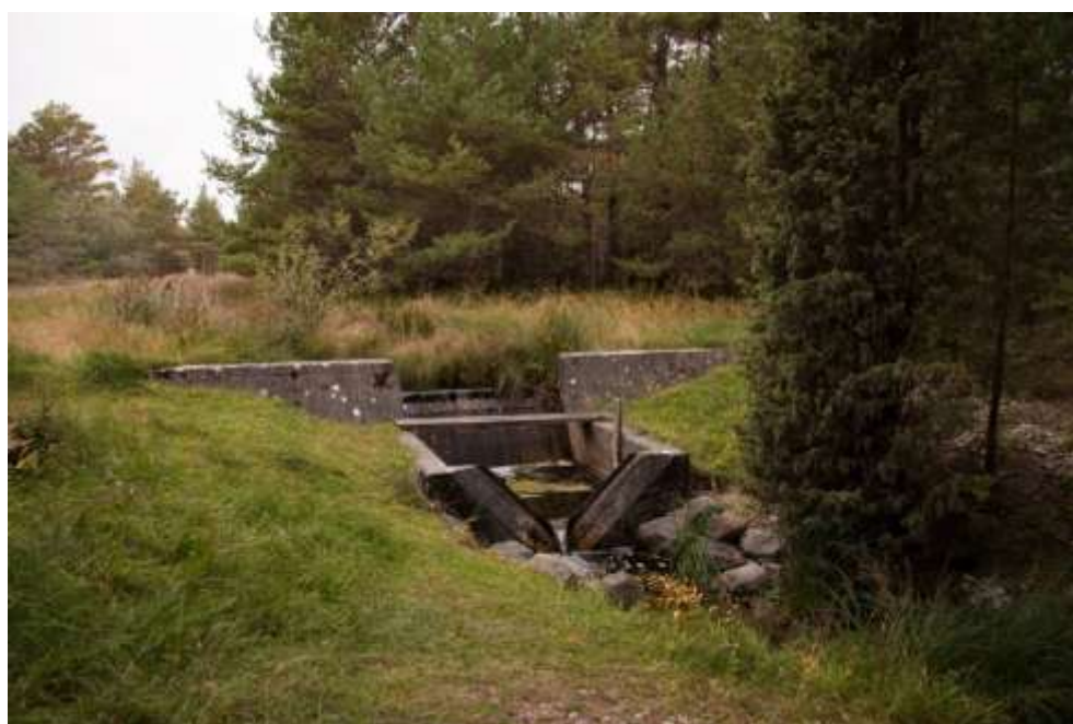
Figur 90. Dammen i Hauån utgör ett totalt vandringshinder för fisk.
