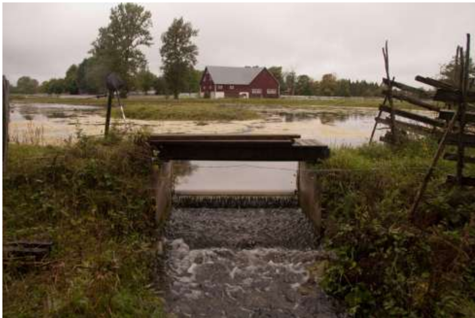
Figur 36. Dammen vid Aner kvarn utgör ett totalt vandringshinder för de flesta fiskar. Uppströms finns fina lekområden.
